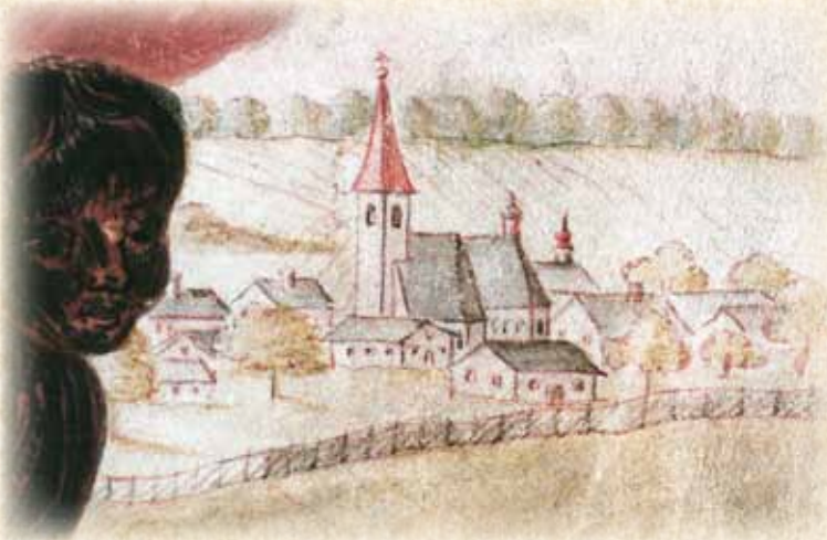
Die alte spätgotische Pfarrkirche ist nach Osten orientiert, der Turm noch mit Spitzdach, steht im Westen, dahinter ist die 1652 gebaute St. Sebastiani-Kapelle mit Dachreiter-Türmchen zu sehen.
